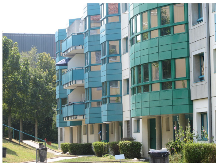
Illustration : Immeuble à démolir de la FJD, 10 à 18 rue Jo-Siffert. Source : FJD
